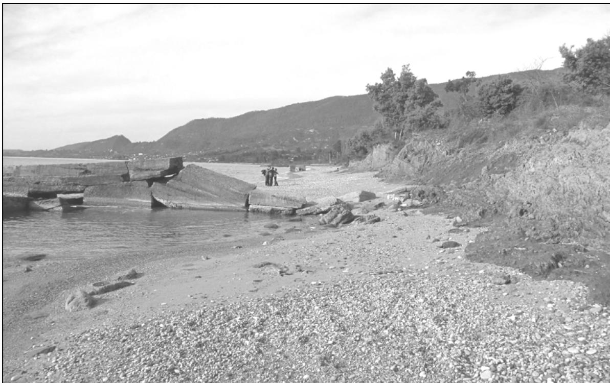
**Рис. 2.** Разрушенная буна.
